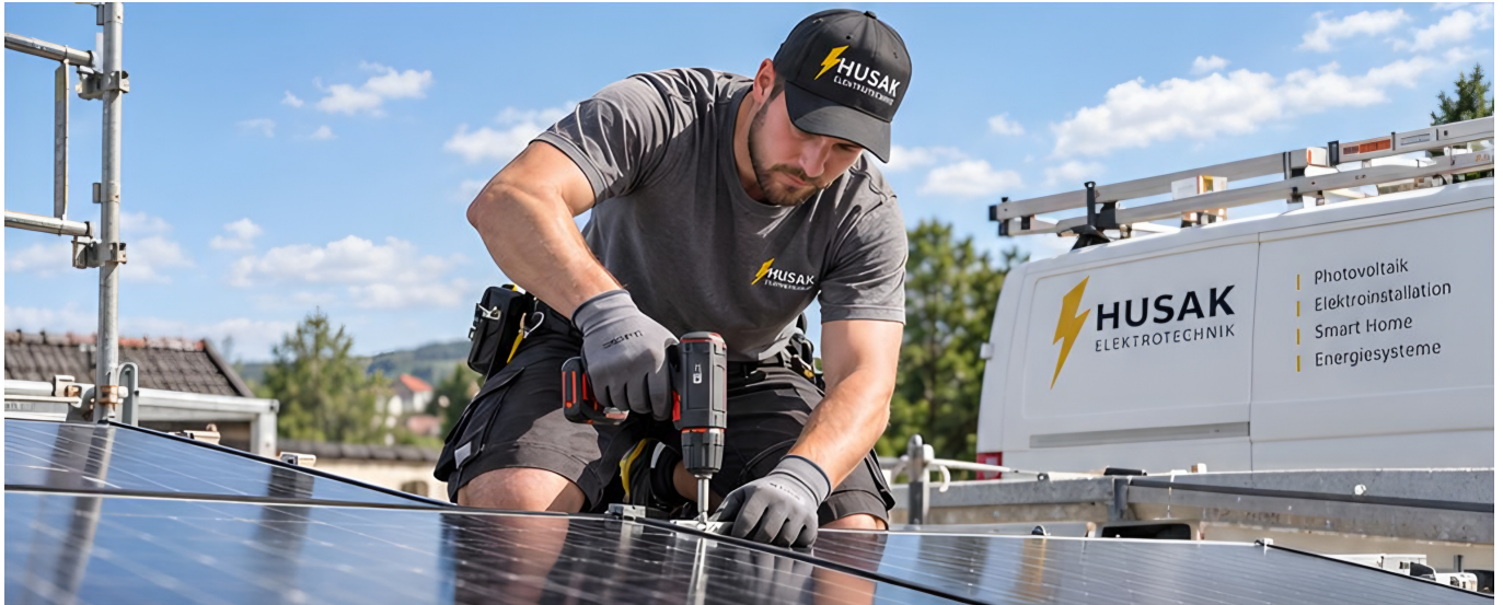
Unterwegs auf der Baustelle und gleichzeitig sauber erreichbar: So passt Telefonie zum Arbeitsalltag von Elektro Husak.
